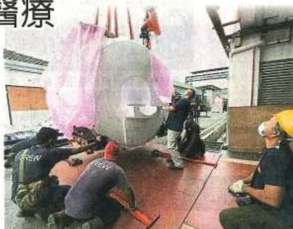
■工作人员小心翼翼地把4吨重的Siemens Magnetom Altea 1.5T磁力共振成像系统 (MRI) 吊下，以推入医院特设的房内。
